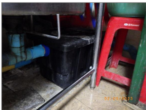
รูปที่ 2-41 ถังดักไขมันเพื่อดักไขมัน และเจ้าหน้าที่คอยตักและดูแลความสะอาด
