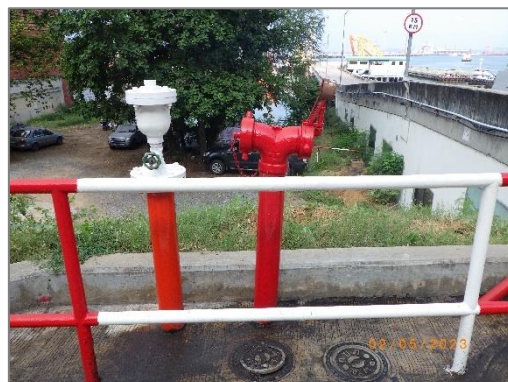
รูปที่ 2-60 หัวจ่ายน้ำดับเพลิง (Fire hydrant)
