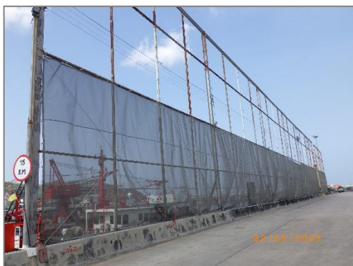
รูปที่ 2-9 การติดตั้งข่ายป้องกันและลดความแรงของลม
